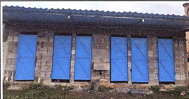
Foto 5: Aquí están pintando las puertas de madera del baño
