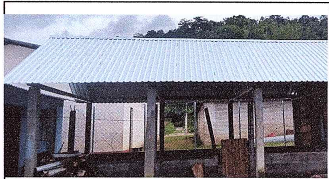
Foto 4: Cocina ya arreglada
