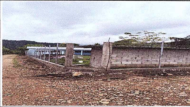
Foto 1: Muro perimetral con tubo ya terminado
