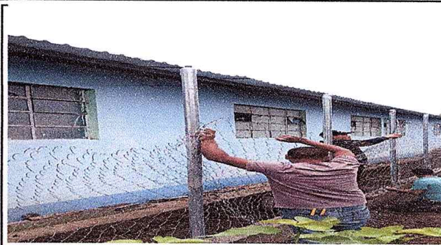
Foto 2: Reparación de muro perimetral con tubo HG y malla galvanizada
