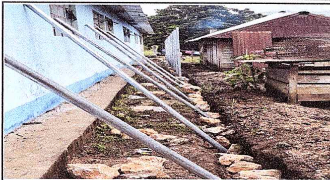
Foto 1: Reparación de muro perimetral con tubo
