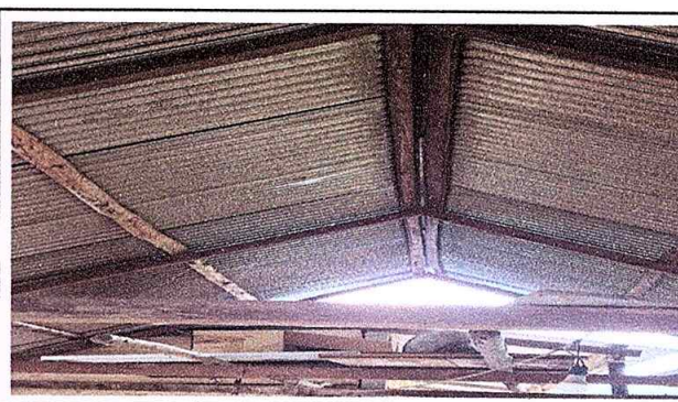
Foto 4: Sustitución de estructura de techo
