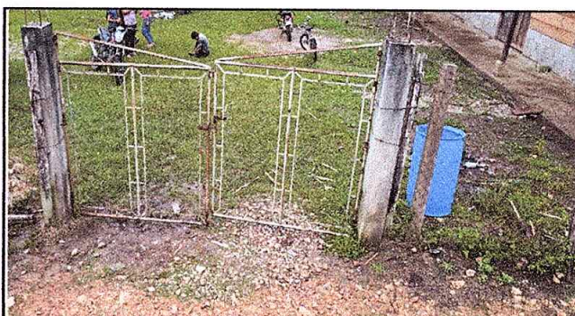
Foto 6: Sustitución de portón de metal
