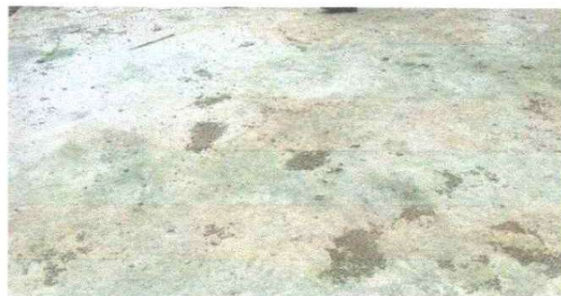
Foto 4: Sustitucion de torta de cemento, por piso de cemento líquido
