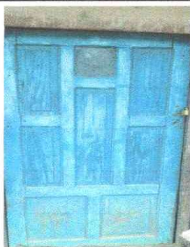
Foto 3: Sustitución de puertas de maderas a metal
