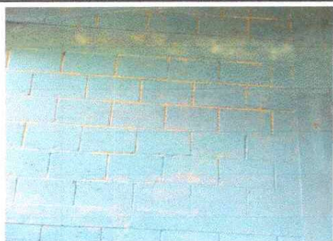
Foto 5: Pintura en muros exteriores e interiores
