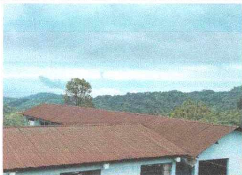
Foto1: Sustitución de lámina, por lámina troqueada aluzinc calibre 26 en aulas
