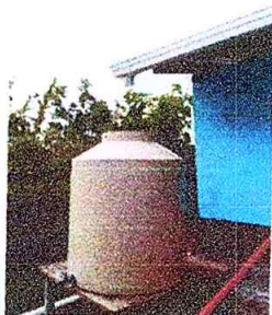
Foto1: cisterna nueva y mantenimiento hecha
