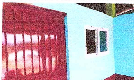
Foto 5: Sustitución de 2 puertas de metal de 2 metros por 1,10
