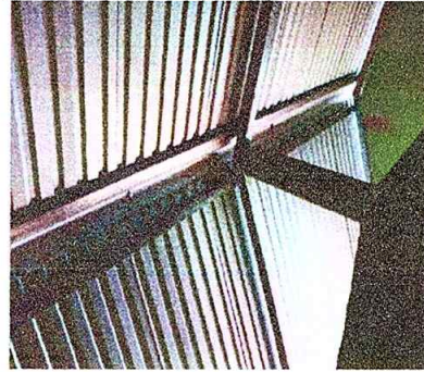
Foto 2: Estructura de techo nuevo
