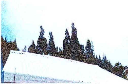
Foto 1: Cubierta de lámina Nueva.
