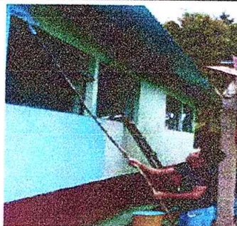
Foto 3: Pintando Paredes de escuela y cocina en mal estado
