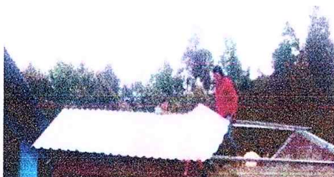
Foto1: Cubierta de lámina cambiando
