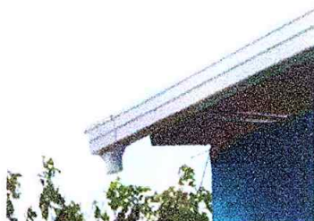
Foto 5: Agregando Canales de agua pluvial deteriorados.
