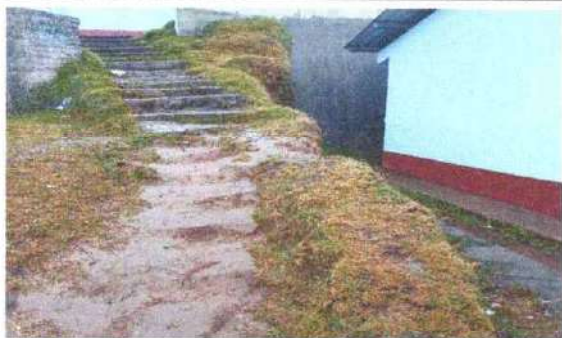
Foto 7: Reparación de planchas de concreto en gradas
