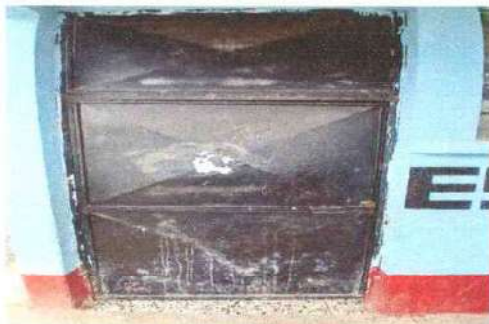
Foto 3: Mantenimiento a estructura (lijado y aplicación de pintura) a puertas
