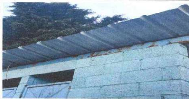
Foto 2: Mantenimiento a estructura de metal (lijado y aplicación de pintura) a soporte de techo en servicios sanitarios
