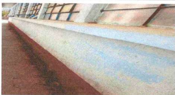
Foto 13: Pintura en muros exteriores e interiores de aulas, cocinas, bodega para cocola y servicios sanitarios
