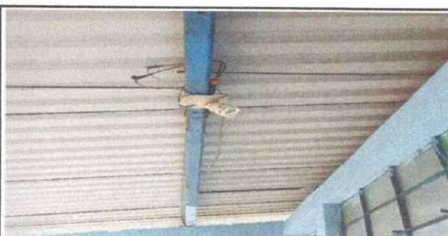
Foto 18: Sustitución de plafoneras
