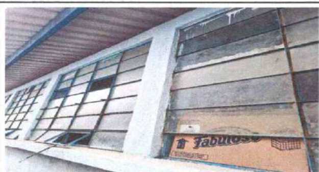
Foto 9: Sustrucción de vidrios en ventanas de aulas
