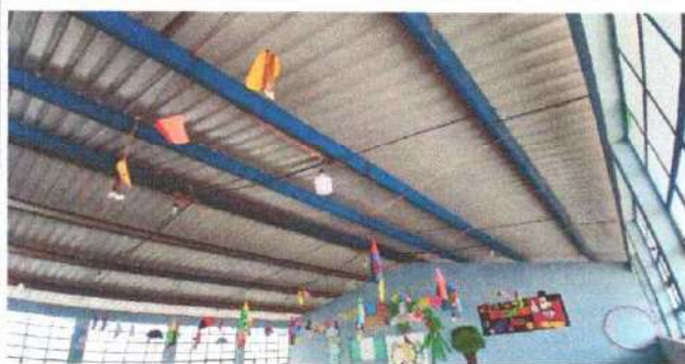
Foto1: Mantenimiento a estructura de metal (lijado y aplicación de pintura) a soporte de techo en aulas
