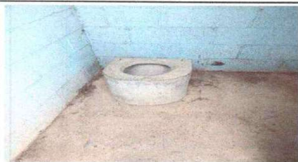
Foto 15: Sustitución de inodoros en servicios sanitarios
