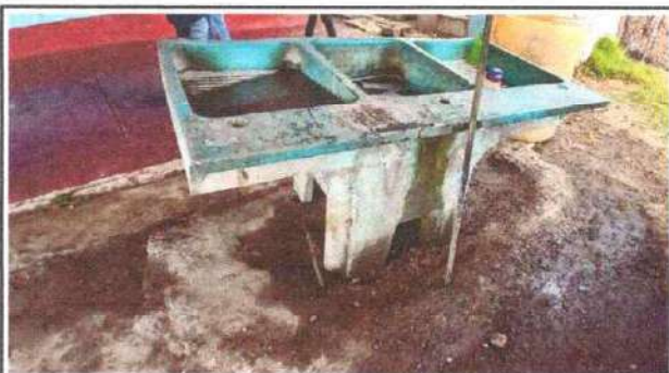
Foto 19: Sustitución de pila de cemento de 2 lavaderos
