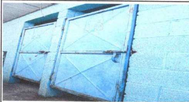
Foto 14: Mantenimiento a estructura (lijado y aplicación de pintura) a puertas de servicios sanitarios
