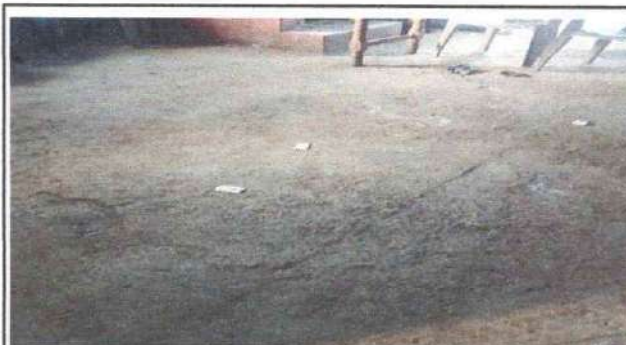
Foto 10: Sustrucción de piso de concreto por piso de granito en cocina
