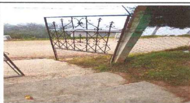
Foto 5: Sustitución de porton de metal
