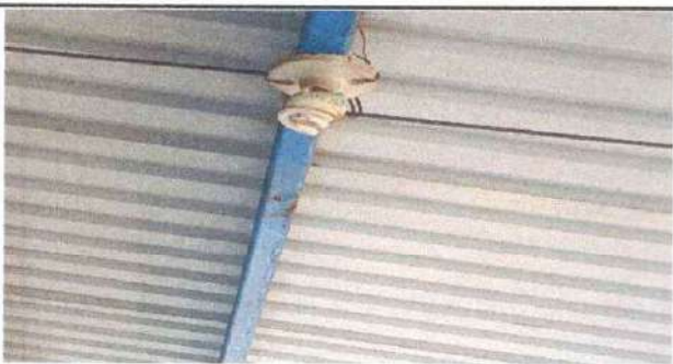
Foto 17: Sustitución de focos ahorradores
