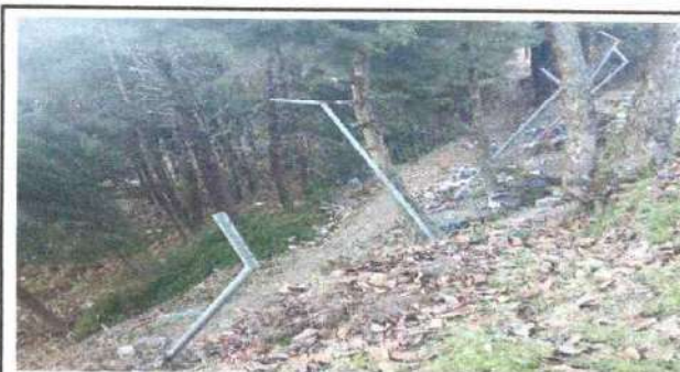
Foto 16: Sustitución de tubos hg y malla galvanizada
