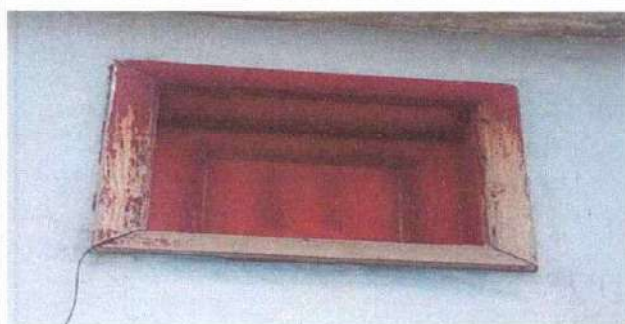
Foto 7: Sustrucción de ventana de madera por metal mas vidrio en cocina
