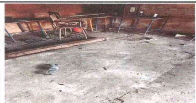
Foto 11: Sustrucción de piso de concreto por piso de granito en bodega para cocina
