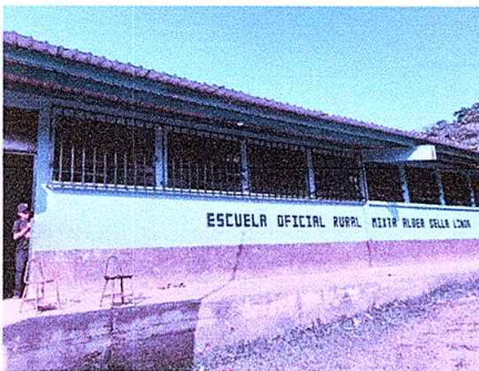
Foto 5: Sustrucción de vidrios terminada.
