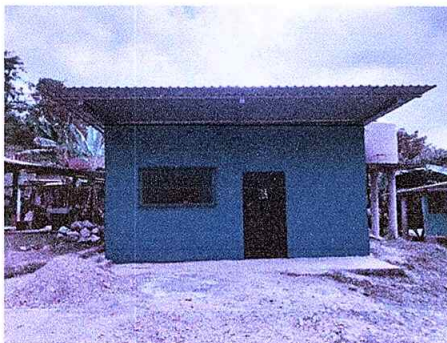
Foto 1: Sustrucción de lámina, por lámina troquelada Alicin calibre 26 terminada.
