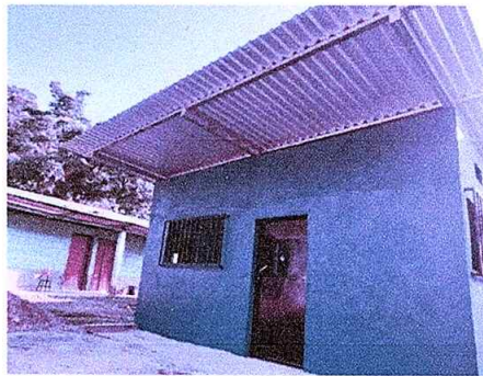
Foto 2: Sustrucción de estructura de soporte de madera por metal terminada.
