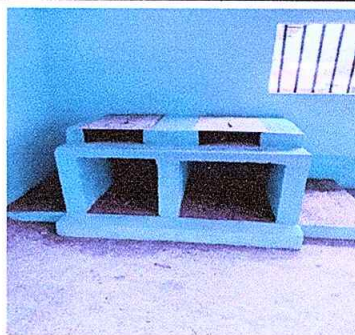
Foto 6: Sustrucción de estufa rural ( completo) terminada.
