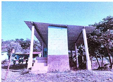
Foto 4: Sustrucción de soporte de madera por metal terminada.
