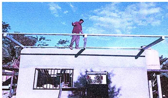
Foto 2: Avance de sustitución de estructura de soporte de madera por metal.
