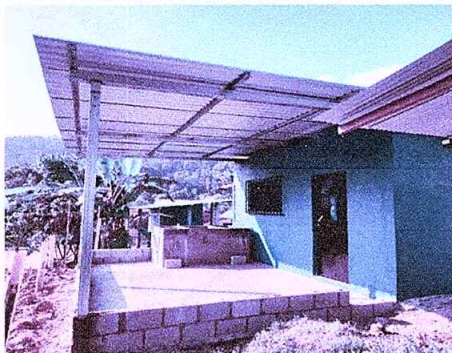
Foto 3: Avance de sustitución de pila de cemento de dos lavadoras.
