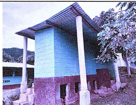
Foto 4: Sustitución de soporte de madera por metal.
