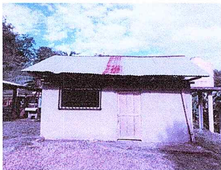
Foto1: Sustitución de lámina, por lámina troquelada Alicin calibre 26.
