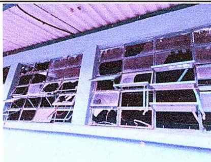
Foto 5: Sustitución de vidrios.
