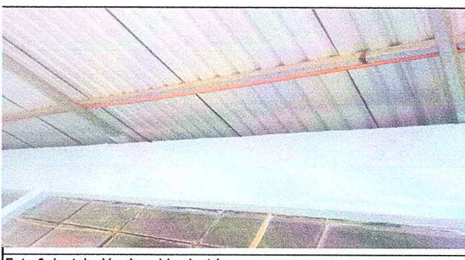
Foto 6: instalación de cable electrico
