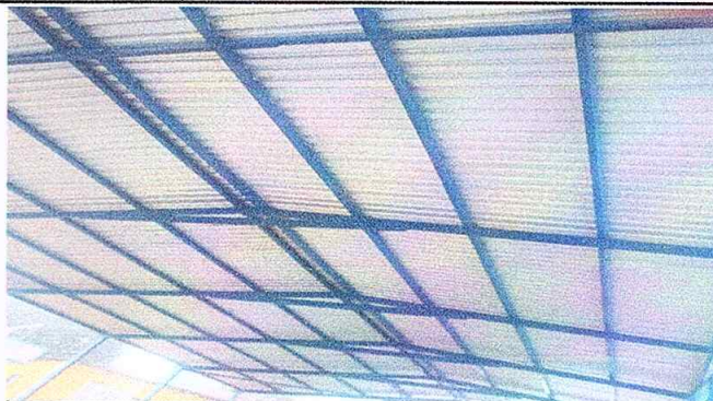
Foto 2: cambio de techo
