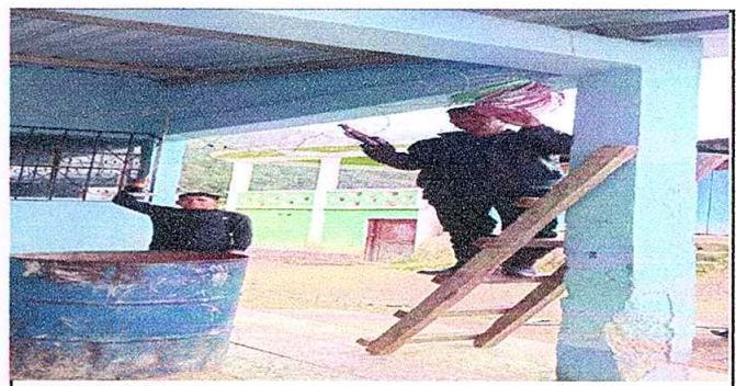
Foto 6: reparación de cable eléctrico
