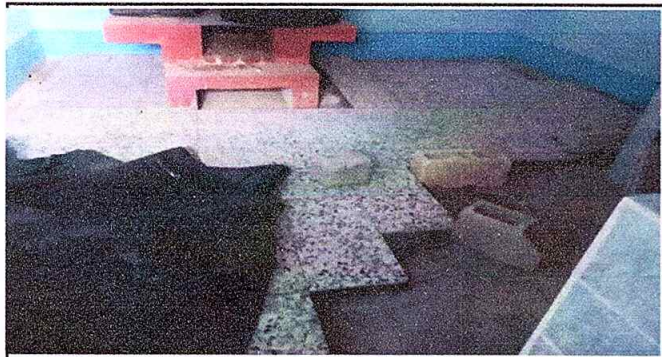
Foto 3: colocación de piso de granito en cocina
