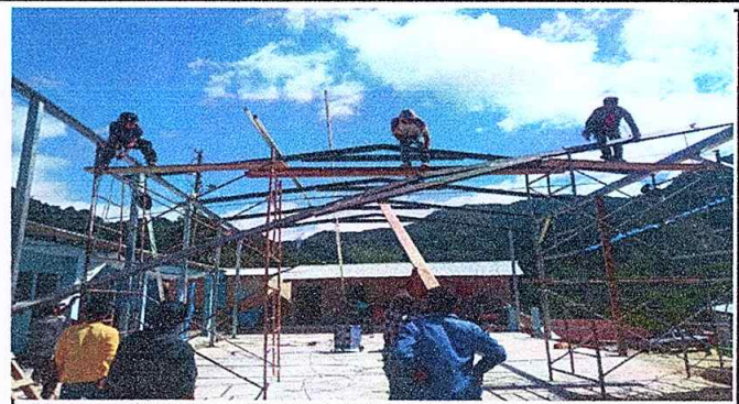
Foto 2: colocación de estructura de techo
