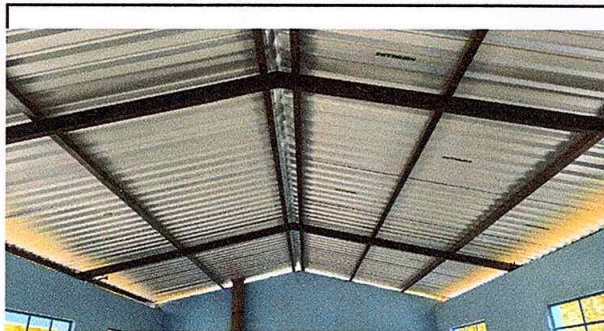
Foto 1: Sustitución de techo de madera y laminas en mal estado
