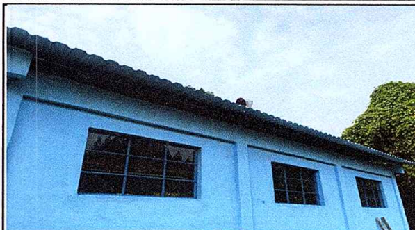
Foto 2: Sustitución de ventana de madera por metal
