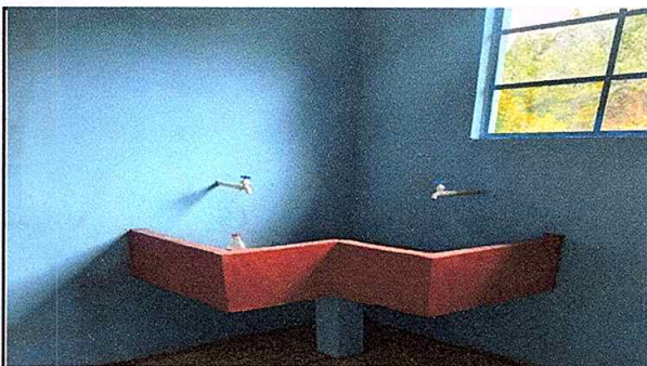
Foto 4: Sustitución de pila de cemento deteriorada
