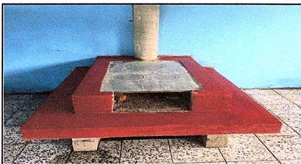
Foto 5: Reparación de estufa rural
