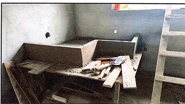
Foto 4: Sustitución de pila de cemento deteriorada
