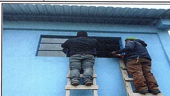
Foto 2: Sustitución de ventana de madera por metal
