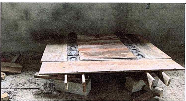
Foto 5: Reparación de estufa rural
