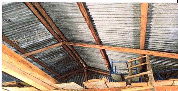
Foto 1: Sustitución de techo de madera y laminas en mal estado
