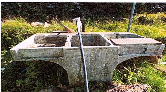
Foto 4: Sustitución de pila de cemento deteriorada
