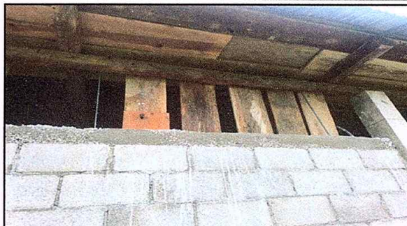
Foto 2: Sustitución de ventana de madera por metal
