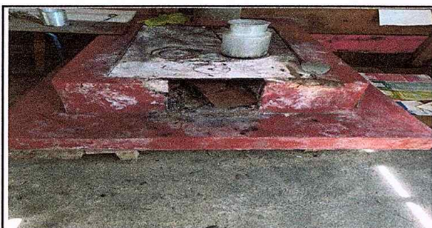
Foto 5: Reparación de estufa rural
