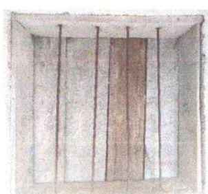
Foto 5: en la imagen se observa que la ventana no está en buenas condiciones, y se cambiará por ventanas de metal mas vidrio
