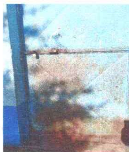
Foto 3: se hará mantenimiento a estructura por lijado, aplicación de pintura
