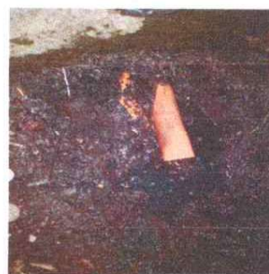
Foto 8: sustitución de tubería de aguas negras
