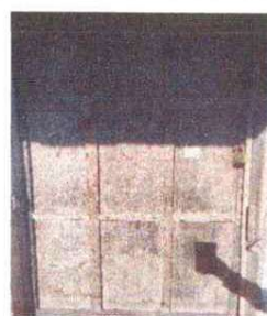
Foto 12: sustitucion de puerta de cocina de madera por metal
