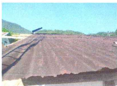
Foto 1: en la fotografia se observa que la lámina se encuentra en mal estado, por la razón se cambiará por láminas troqueladas aluzinc
