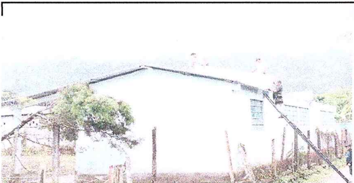
Foto 9: ya fueron colocadas los soportes de metal en beneficio de la comunidad educativo
