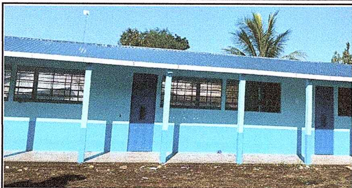
Foto 1: en la fotografía podemos observar que las laminas ya fueron sustituidas por laminas troqueladas
