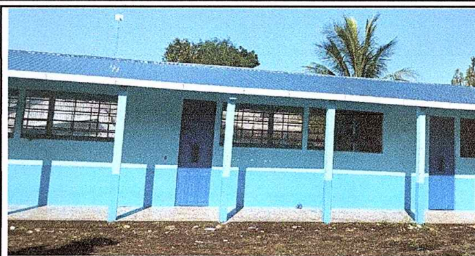
Foto 2: en la misma fotografía se aprecia ver las costaneras de metal ya instaladas
