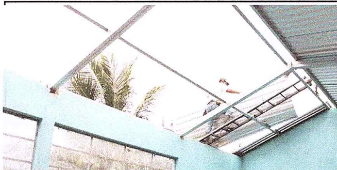
Foto 8: con la instalacion del techo la escuela durará mucho mas tiempo
