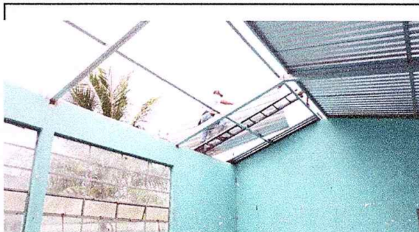
Foto 8: en la fotografía se puede observar la instalacion del techo de la escuela
