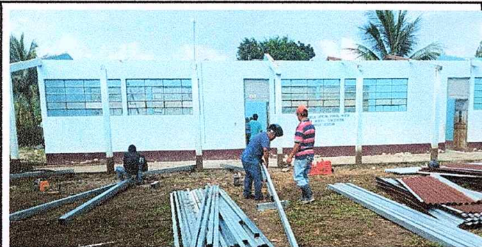
Foto1: en la fotografia podemos observar queestan quitando las laminas deterioradas, para sustituirlas por nuevas
