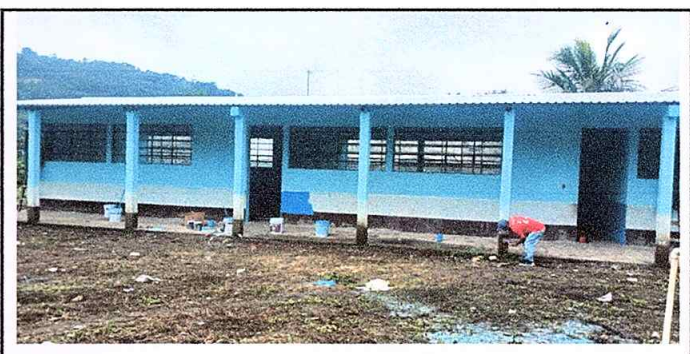
Foto 6: en la fotografias se puede apreciar que ya retiraron las puertas antiguas
