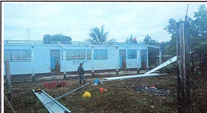
Foto 2: en la fotografia se puede observar que estan instalando las costaneras
