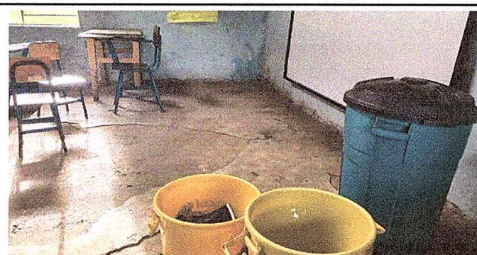
Foto 3: Sustitución de piso deteriorado por piso de granito
