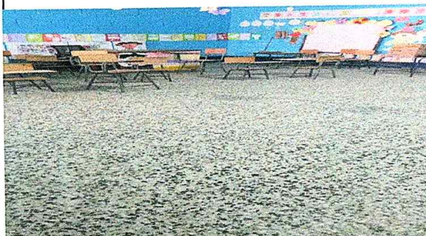
Foto 3: Finalización de Sustitución de piso de granito.
