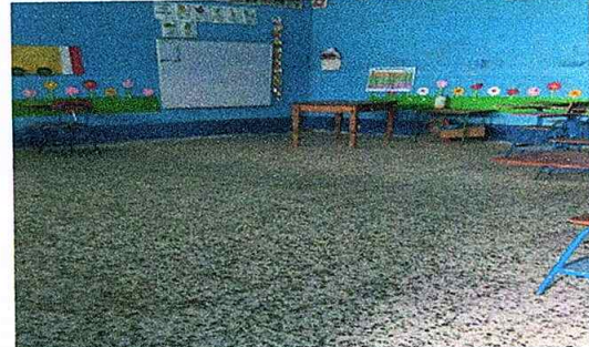
Foto 2: Finalización de Sustitución de piso de granito.
