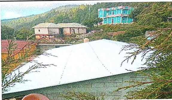
Foto 5: Finalización de la colocación de láminas Troqueladas.
