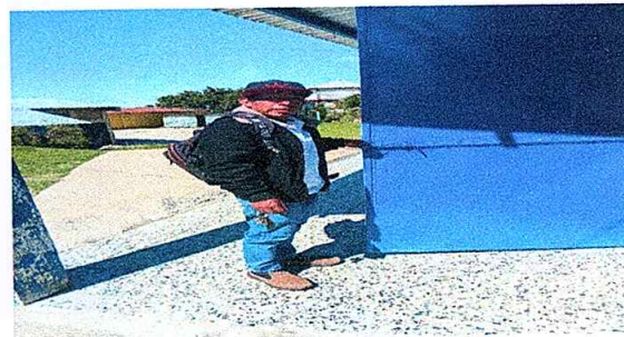
Foto 6: Finalización de Sustitución de puertas por metal.
