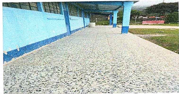
Foto 4: Finalización de Sustitución de piso de granito.
