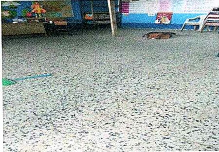
Foto 1: Finalización de Sustitución de piso de granito.
