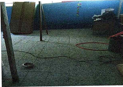
Foto 1: Sustitución de piso de cemento líquido por piso de granito
