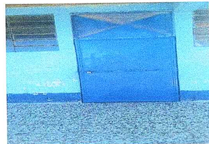
Foto 6: Sustitución de puertas de madera por metal
