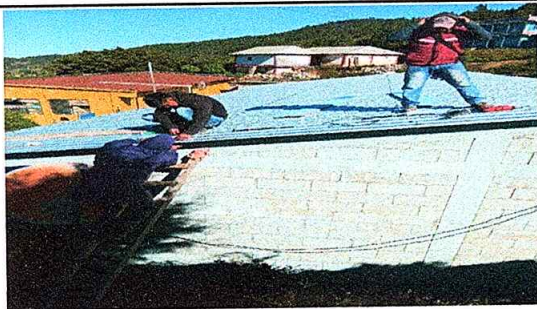
Foto 5: La colocación de láminas Troqueladas
