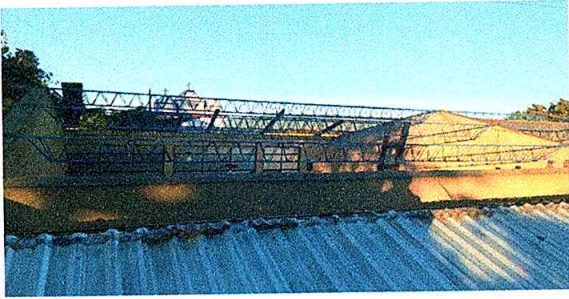
Foto 7: El cuarto salon de aula, la estructura portante del techo ya esta lijado con fondo y doble capa de pintura anticorrosiva.
