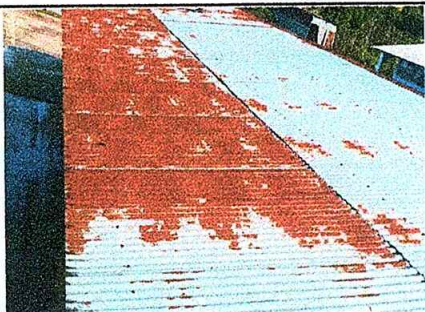
Foto 5: Sustitución de láminas en mal estado
