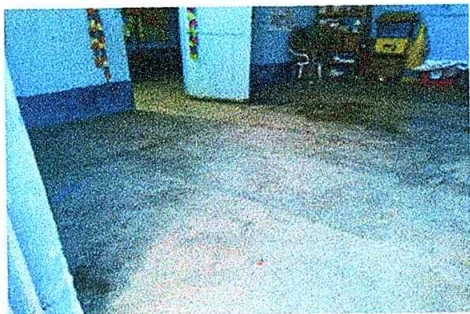
Foto 1: Sustitución de piso de cemento líquido por piso de granito
