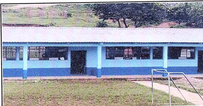
Foto 5: Sustitución de estructuras de costaneras
