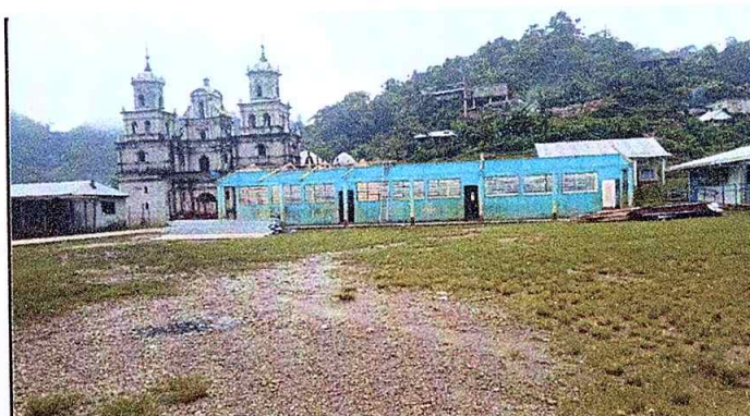
Foto 4: Techo en proceso
