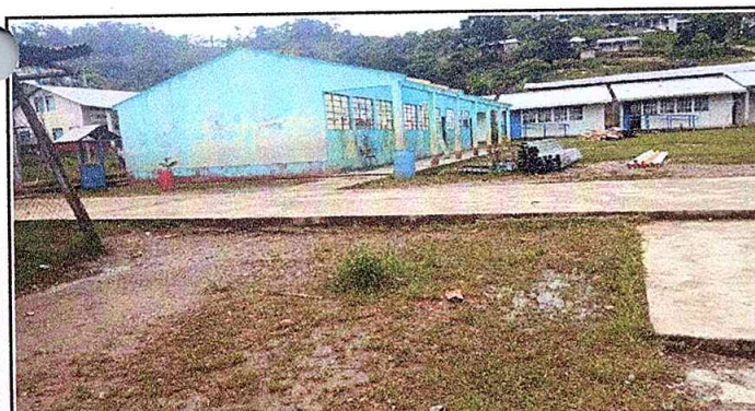
Foto 5: Colocación de estructura
