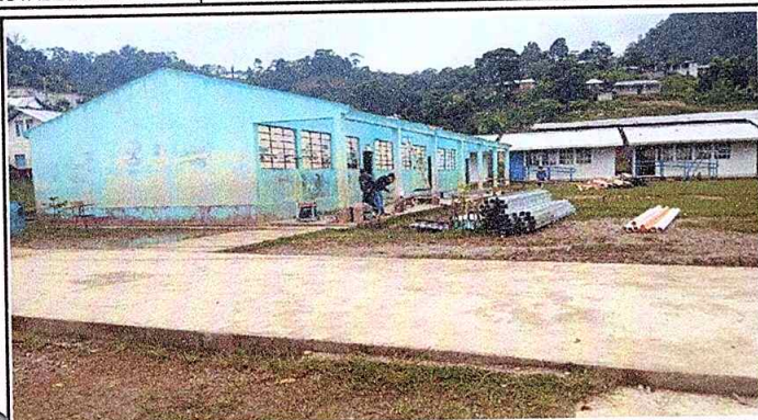
Foto1: Sustitución de lamina por lamina troquelada
