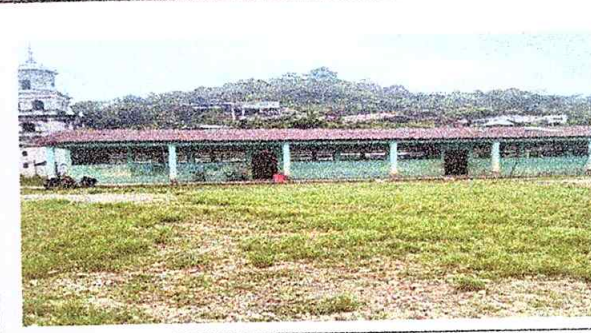
Foto 4: Pinturas en muro exteriores e interiores.
