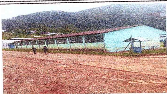
Foto1: Sustrución de lámina, por lámina
