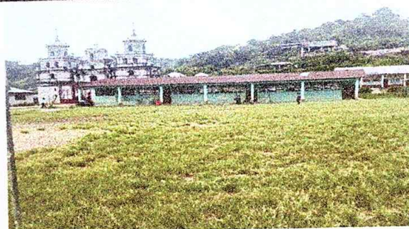
Foto2: Sustrución de estructura de madera a metal.
