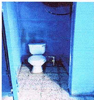
Foto 7 : MEJORAMIENTO DE INODORO
