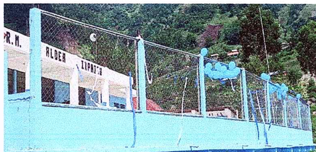
Foto 8: SUSTITUCION DE MALLA GALVANIZADA POR MALLA GALVANIZADA
