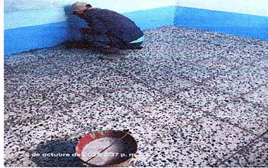
Foto 4: SUSTITUCION DE PISO DE TORTA DE CONCRETO POR PISO DE GRANITO
