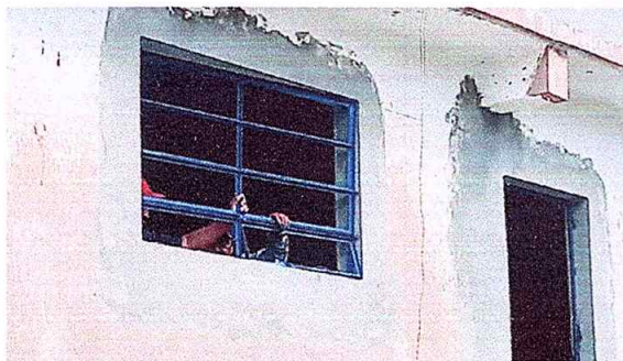
Foto 3: SUSTITUCION DE VENTANAS DE MADERA POR METAL MAS VIDRIO
