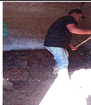
Foto 4: SUSTITUCION DE PISO DE TORTA DE CONCRETO POR PISO DE GRANITO
