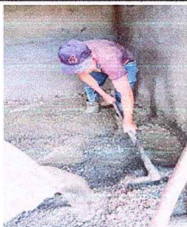
Foto 5: SUSTITUCION DE PISO DE TORTA DE CEMENTO POR TORTA DE CEMENTO
