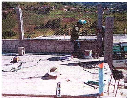
Foto 8: SUSTITUCION DE MALLA GALVANIZADA POR MALLA GALVANIZADA
