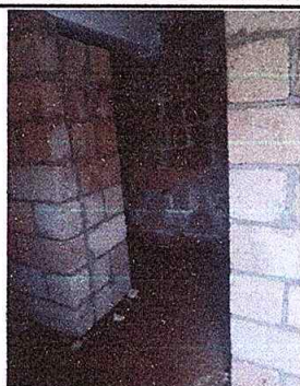
Foto 1: MEJORAMIENTO DE PUERTAS EN SERVICIO SANITARIO
