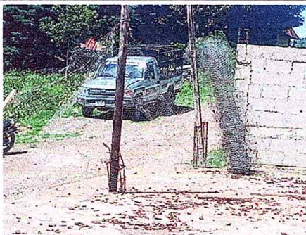
Foto 8: SUSTITUCION DE MALLA GALVANIZADA POR MALLA GALVANIZADA
