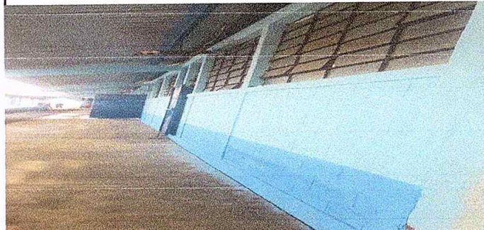
Foto 2: Trabajo terminado de pintada muros exteriores.
