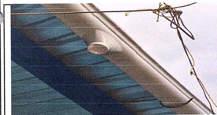
Foto 5: Trabajo terminado de instalación de canales de pvc para agua plubial.
