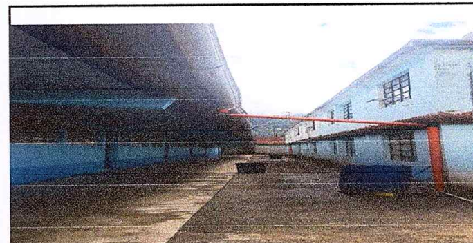
Foto 6: Trabajo terminado de instalación de tubos para bajadas de agua
