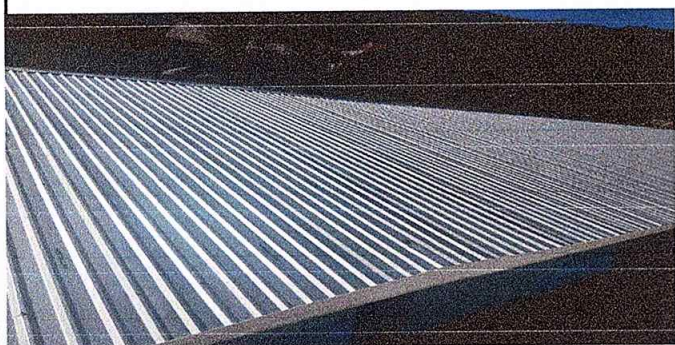
Foto 1: Trabajo terminado de instalación de techo de lamina troquelado.
