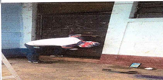
Foto 5: Reparación de puertas
