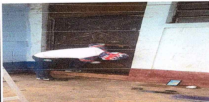
Foto 5: Proceso de lijado de puertas de metal.
