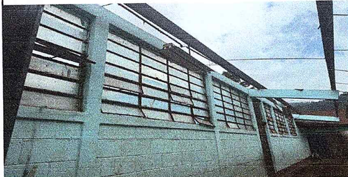
Foto 2: Sustrucción de techo, ya preparando el entechado
