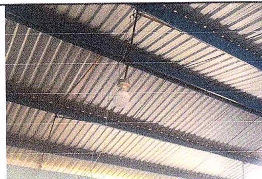
Foto 6: Instalación de láminas truqueladas.
