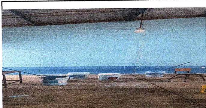
Foto 3: Pintando de muros interiores de las aulas
