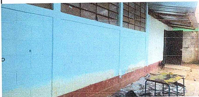
Foto 4: Aplicación de pintura a muros exteriores.
