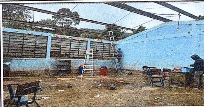
Foto 2: En proceso de mantenimiento y pintada de soporte de techo.
