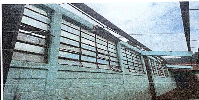
Foto 1: Mantenimiento a estructura de soporte de techo
