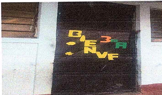
Foto 2: Reparación de puertas de aulas
