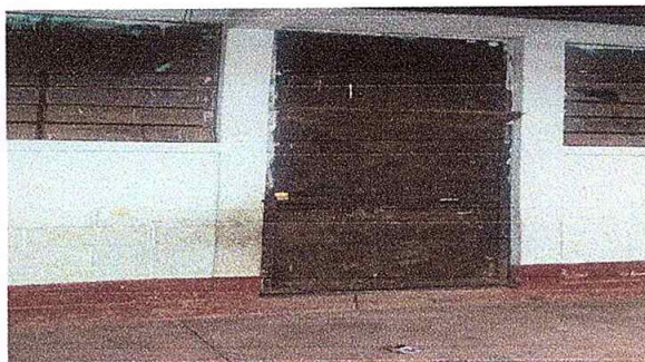
Foto 4: Reparación de puertas de aulas
