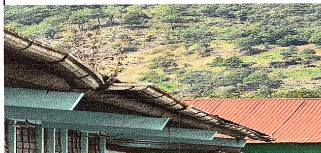
Foto 5: Canales deterioradas
