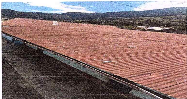
Fpto 1:Sustitución de techo de aulas
