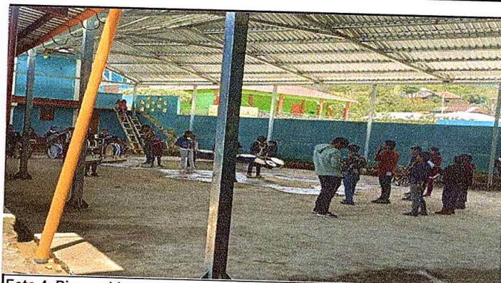
Foto 4: Piso en buen estado
