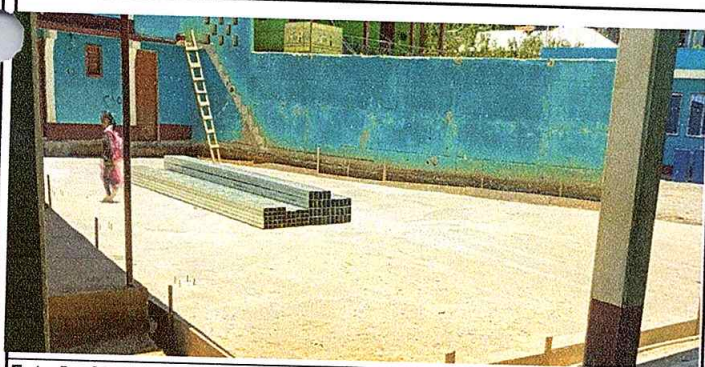
Foto 5: Mejoramiento de área del patio
