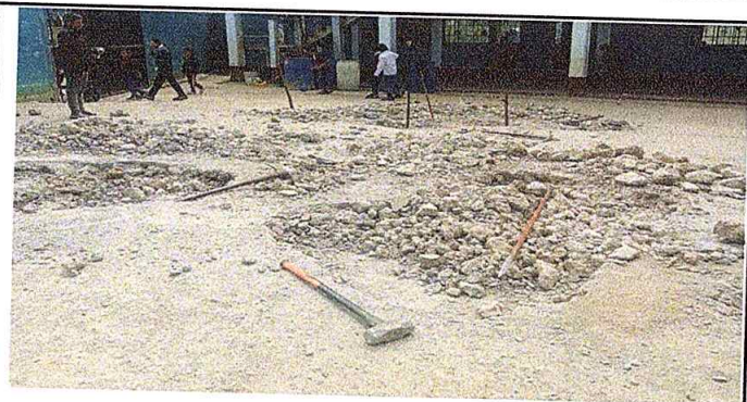
Foto 3: Trabajando con el piso
