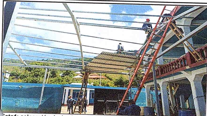
Foto1: colocación de laminas
