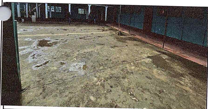
Foto 5: Mejoramiento de ária del patio
