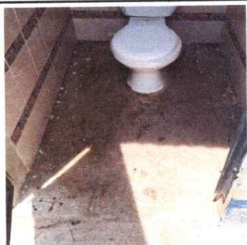
Foto 5: Sustitución de concreto por piso de granito en el baño
