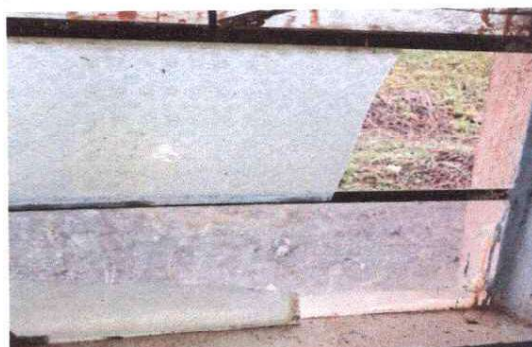
Foto 4: Sustitución de vidrios en ventanas
