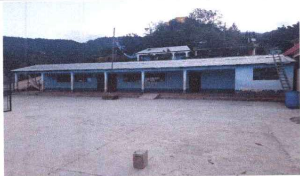
Foto1: Sustitución de lamina troquelada calibre 26
