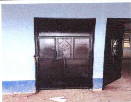
Foto 3: Mantenimiento a estructura lijado aplicación de pintura de puertas en aulas
