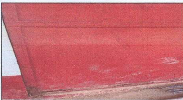
Foto 5: Cambio de puertas
