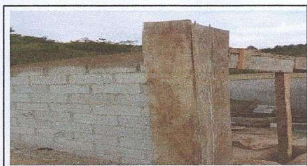
Foto 4: mejoramiento de estructura de soporte en baño
