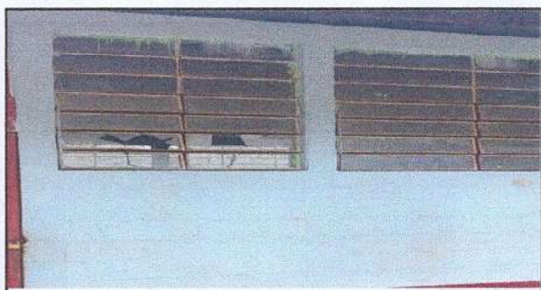
Foto 6: sustitución de vidrios quebrados
