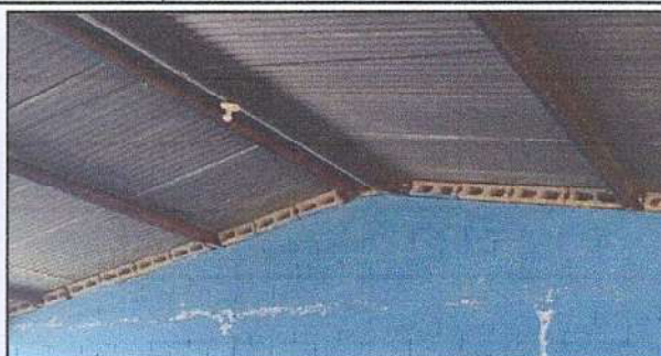
Foto 2: Sustitución de capote de lamina troquelada
