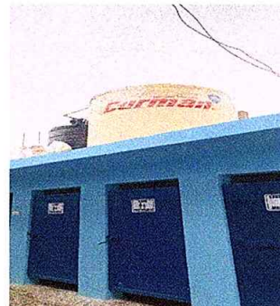
Foto 2: depósito de agua nuevo
