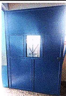
Foto 11: reparación de puerta de la dirección
