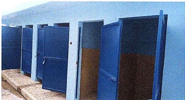
Foto 1: cambio de puertas de metal
