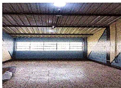
Foto 10: colocación de piso de granito
