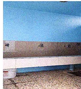
Foto 6: lavamanos con azulejo y pintura
