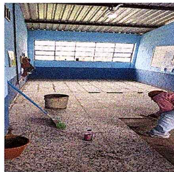
Foto 10: colocación de piso de granito
