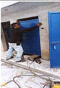
Foto1: cambio de puertas de metal
