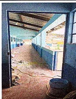
Foto 11: reparación de puerta de la dirección
