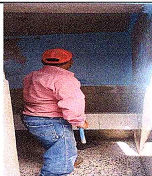
Foto 6: colocación de azulejo y pintura en lavamanos
