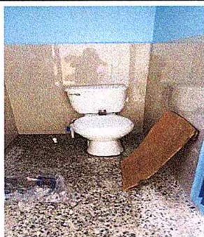
Foto 5: sustitución de tazas nuevas
