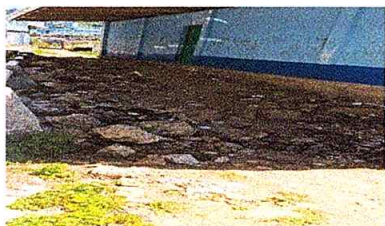
Foto 9: mejoramiento de patio
