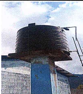
Foto 2: cambio de depósito de agua
