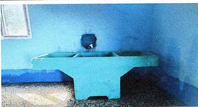
Foto 3: Colocación de piso de granito en la cocina y sustitución de pila de cemento de dos alas terminado.
