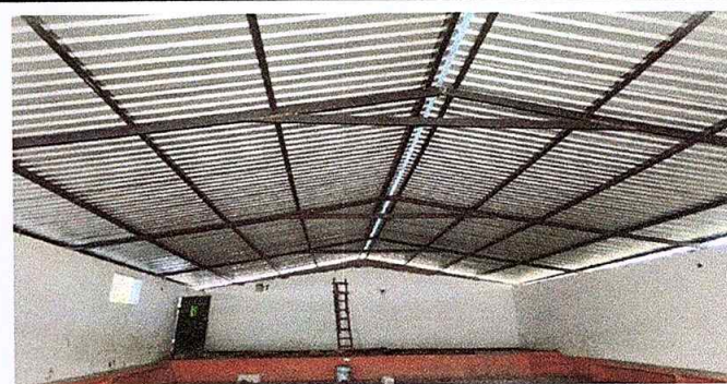
Foto 4: Colocación de estructura de techo terminado
