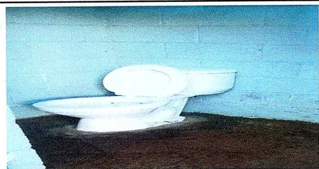
Foto 5: Colocación de inodoro terminado
