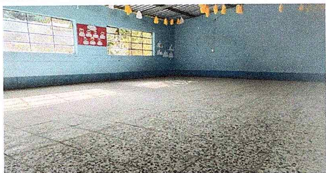
Foto1: Instalación de piso de granito terminado
