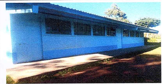
Foto 6: Pintura en el interior y exterior en las aulas terminado.
