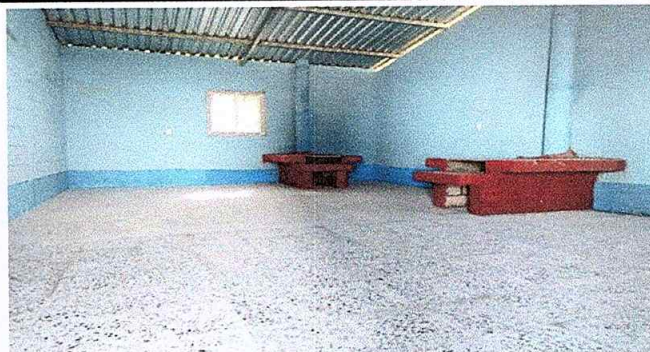
Foto 2: Reparación de estufa rural terminado (completo)
