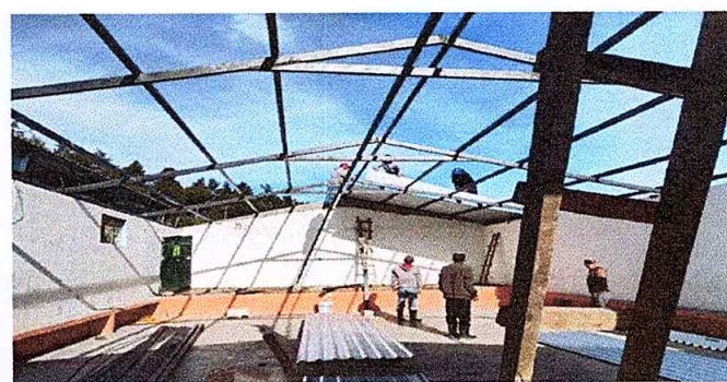
Foto 4: Colocación de estructura de techo.
