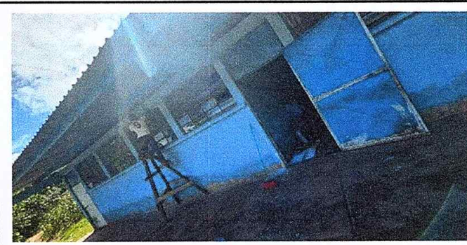
Foto 6: Pintura en el interior y exterior en las aulas.
