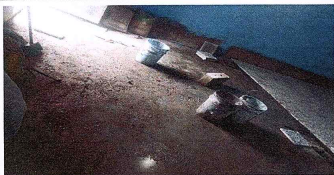
Foto 3: Colocación de piso de granito en la cocina y sustitución de pila de cemento de dos alas
