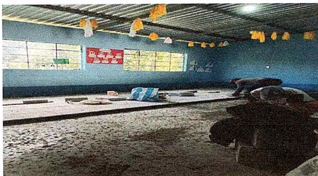
Foto1: Colocación de piso de granito en cocina en el salon de clases.
