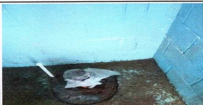
Foto 5: Colocación de inodoro
