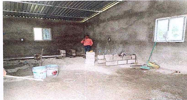
Foto 2: Reparación de estufa rural (completo)
