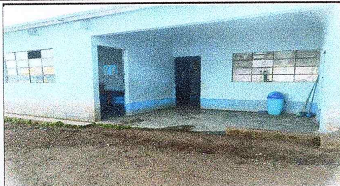
Foto1: Sustrucción de ventanas por nuevas y sustrucción de pisos de granito.
