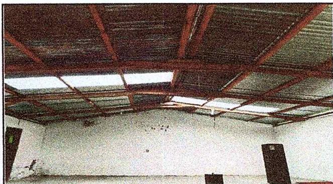
Foto 4: Sustrucción de láminas en mal estado por láminas troqueladas. Sustrucción de vigas de maderas por metal.
