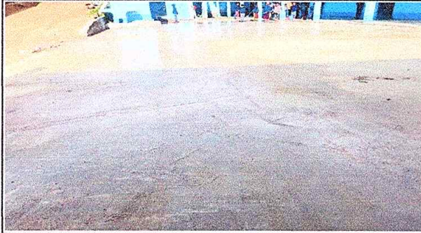
Foto 1: piso de patio terminado
