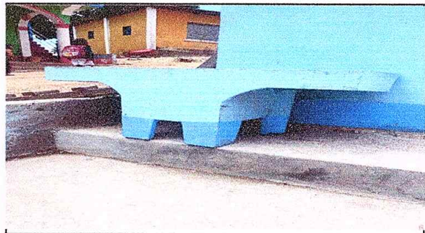
Foto 4: pila de cemento colocado
