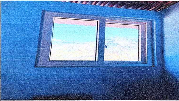
Foto 3: ventana de cocina colocado y terminado
