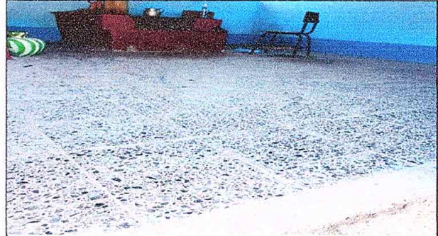
Foto 2: piso de de la cocina terminado
