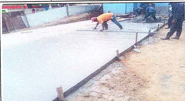
Foto 1: Fundición de piso de patio
