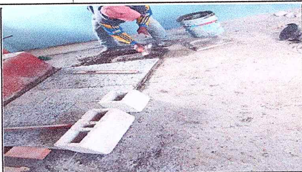
Foto 2: piso de la cocina en proceso de colocación de aceramicos
