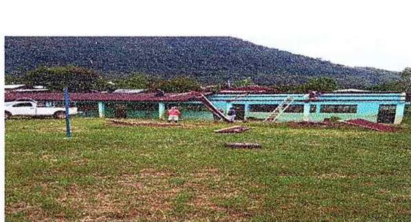
Foto2: Remozamiento en proceso.
