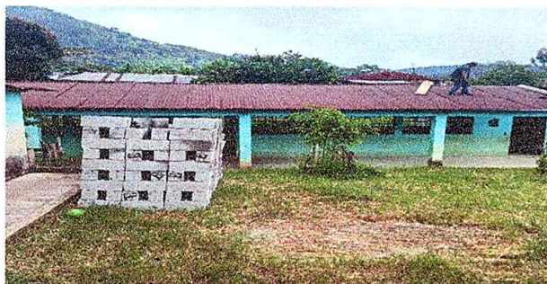
Foto1: Sustrución de lámina, por lámina
