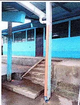
Foto 19: Mejoramiento con bajada de agua pluvial por tubo pvc de 3"
