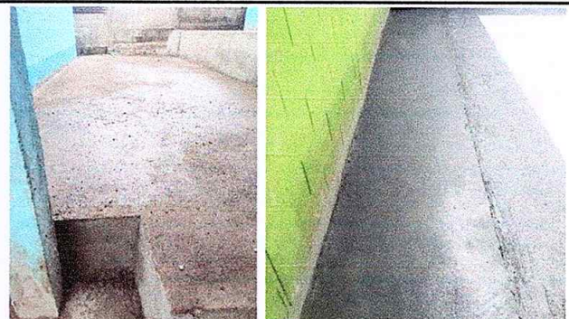
Foto 12: Reparación de plancha de concreto de patio
