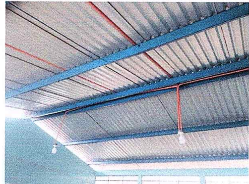
Foto 2: Sustitución de ducto eléctrico mas accesorio
