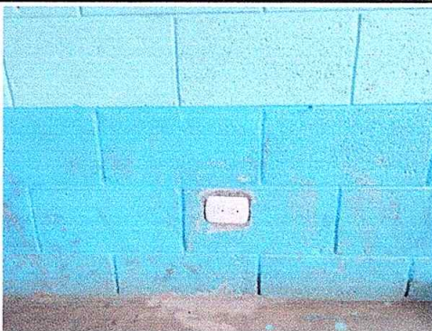
Foto 3: Sustitución de tomacorrientes dobles
