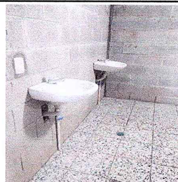
Foto 16: Mejoramiento con lavamanos
