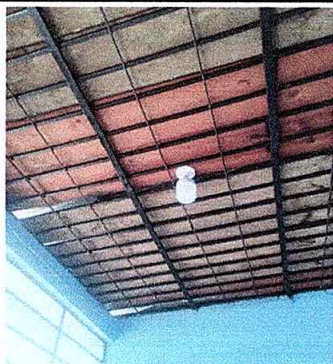
Foto 15: Sustitución de focos ahorradores
