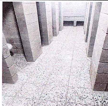
Foto 14: Mejoramiento con piso de granito
