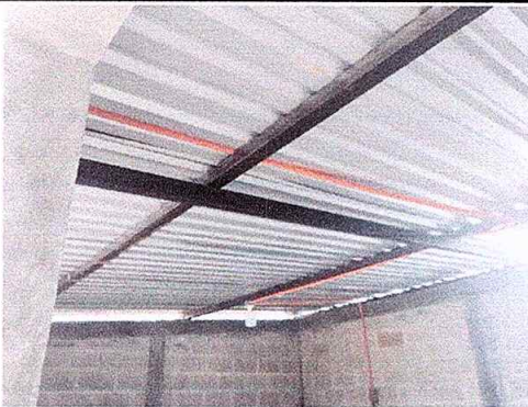
Foto 9: Mejoramiento con estructura soporte de techo
