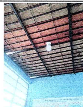
Foto 6: Sustitución de plafoneras
