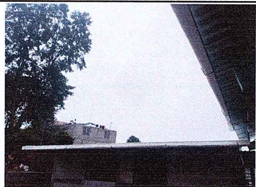
Foto 10: Mejoramiento con lámina troquelada aluzinc calibre 26
