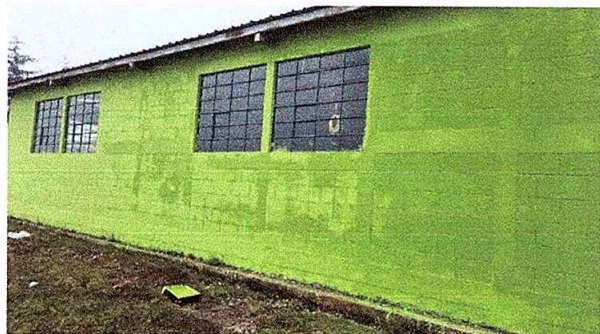
Foto 13: Cerramiento con una hilada de block en aulas
