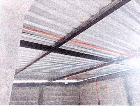
Foto 1: Reparación de cableado eléctrico
