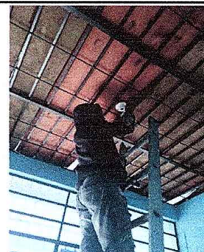
Foto 6: Sustitución de plafoneras
