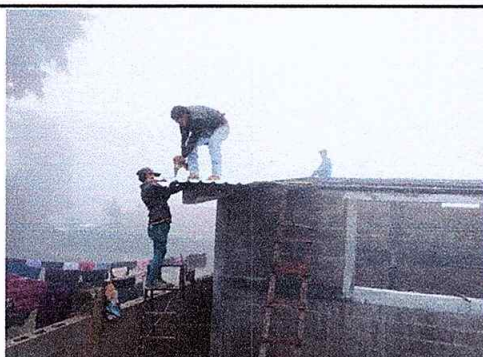
Foto 11: Mejoramiento con elementos de fijación
