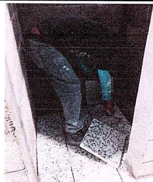
Foto 14: Mejoramiento con piso de granito
