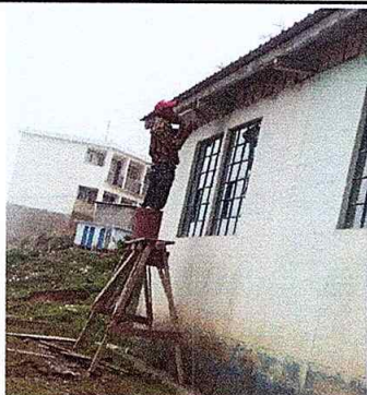
Foto 13: Cerramiento con una hilada de block en aulas
