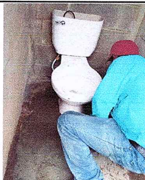
Foto 8: Sustitución de inodoro
