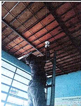
Foto 15: Sustitución de focos ahorradores
