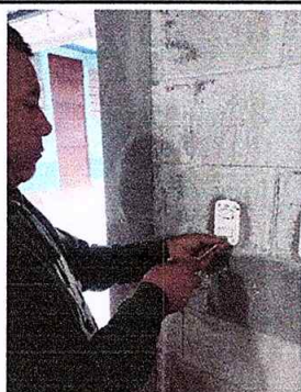
Foto 5: Sustitución de interruptores dobles
