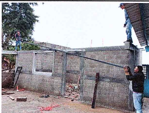
Foto 9: Mejoramiento con estructura soporte de techo
