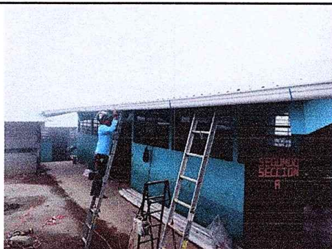
Foto 17: Mejoramiento con canal de pvc de 6 metros de largo
