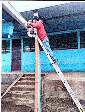
Foto 19: Mejoramiento con bajada de agua pluvial por tubo pvc de 3"
