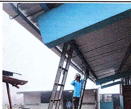
Foto 18: Mejoramiento con soporte o pescante de metal
