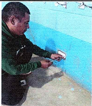
Foto 3: Sustitución de tomacorrientes dobles
