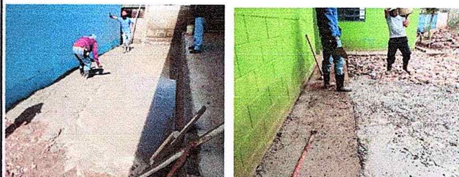
Foto 12: Reparación de plancha de concreto de patio
