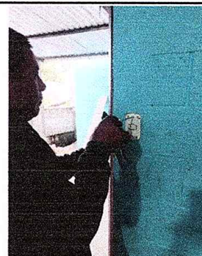
Foto 4: Sustitución de interruptores simples
