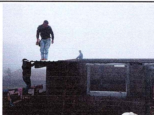
Foto 10: Mejoramiento con lámina troquelada aluzinc calibre 26
