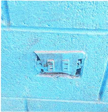
Foto 3: Sustitución de tomacorrientes dobles
