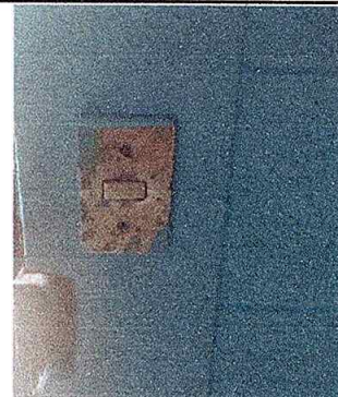
Foto 4: Sustitución de interruptores simples
