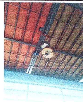
Foto 16: Sustitución de focos ahorradores
