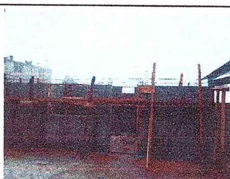
Foto 12: Mejoramiento con capote de lámina troquelada aluzinc calibre 26
