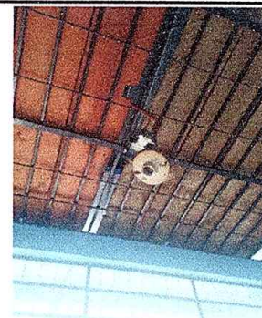
Foto 6: Sustitución de plafoneras
