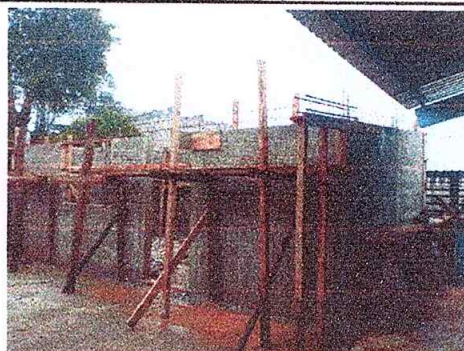
Foto 10: Mejoramiento con lámina troquelada aluzinc calibre 26
