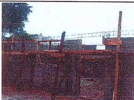
Foto 11: Mejoramiento con elementos de fijación
