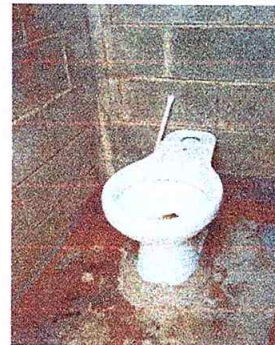
Foto 8: Sustrucción de inodoro
