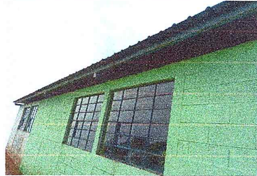
Foto 14: Cerramiento con una hilada de block en aulas
