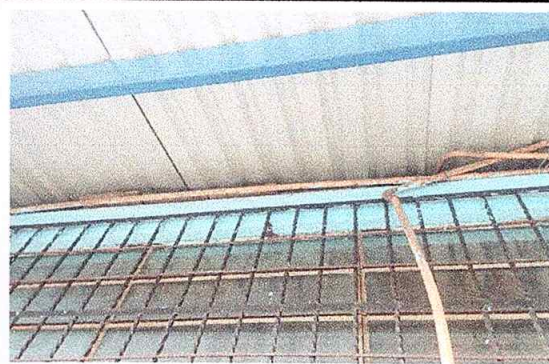
Foto 2: Sustitución de ducto electrico mas accesorio
