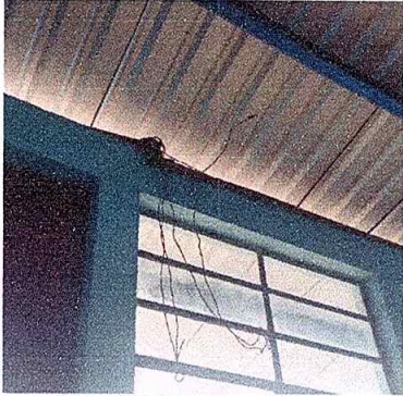
Foto 1: Reparación de cableado electrico
