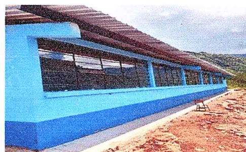
Foto 4: culminación de pintura en muros exteriores e interiores
