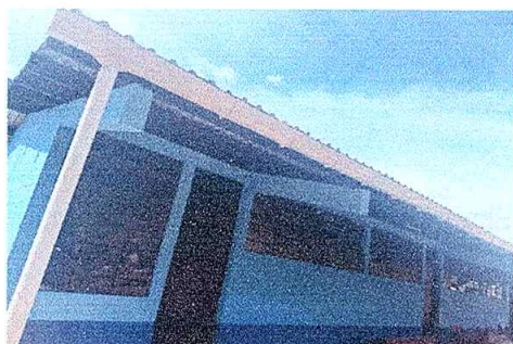
Foto 1: Culminación de colocación de techo
