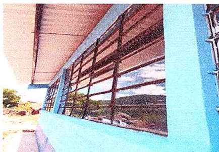
Foto 5: colocación de ventanas.
