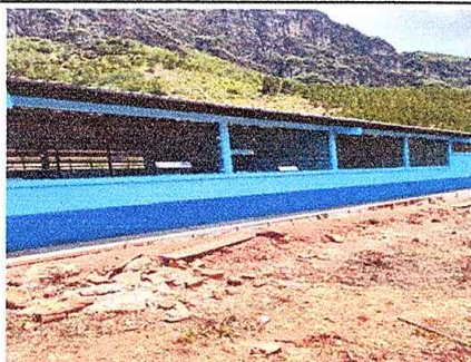
Foto 3: culminación de sustitución de piso de torta
