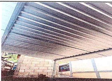
Foto 5: colocación de lámina de techo.
