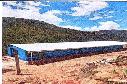
Foto 2: culminación de remozamiento del centro educativo
