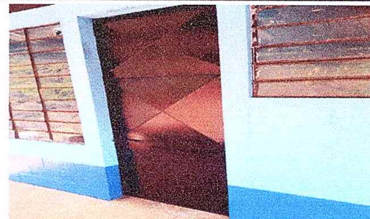
Foto 6: colocación de pintado en puertas
