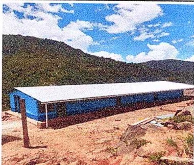
Foto 1: Culminación de remozamiento del establecimiento.
