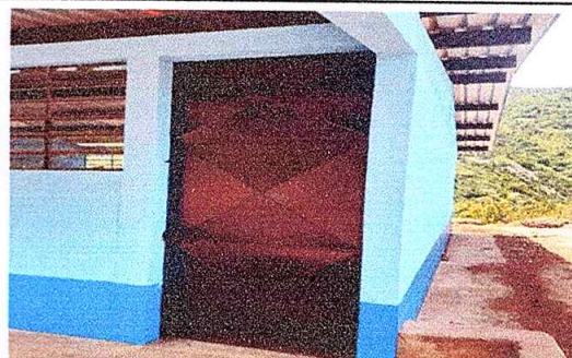
Foto 2: colocación de puertas.
