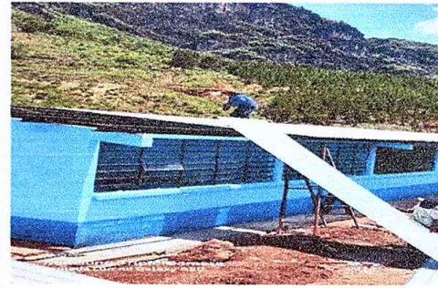
Foto 2: colocación de estructura de techo
