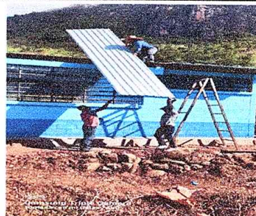
Foto 4: colocación de lamina de techo.
