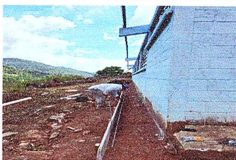
Foto 3: fundición de piso de torta.
