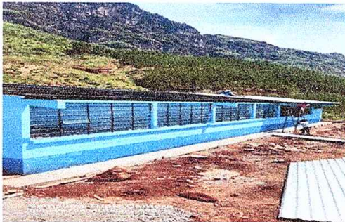
Foto 1: colocación de lamina para techo del centro educativo
