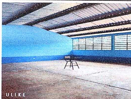
Foto1: pintado de paredes interiores de las aulas.
