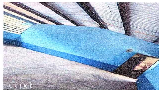
Foto 6: pintado interior de las aulas
