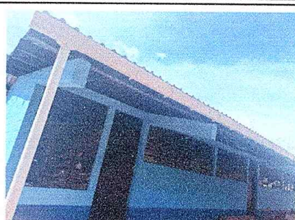
Foto 2: colocación de canales para agua pluvial.
