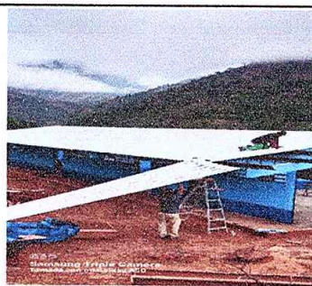
Foto 6: colocación de lamina para techo del centro educativo
