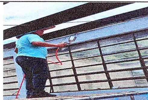
Foto 3: procedimiento a realizar el pintado y mantenimiento de costaneras
