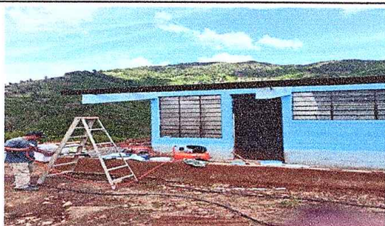
Foto 5: pintado de paredes exteriores de las aulas.
